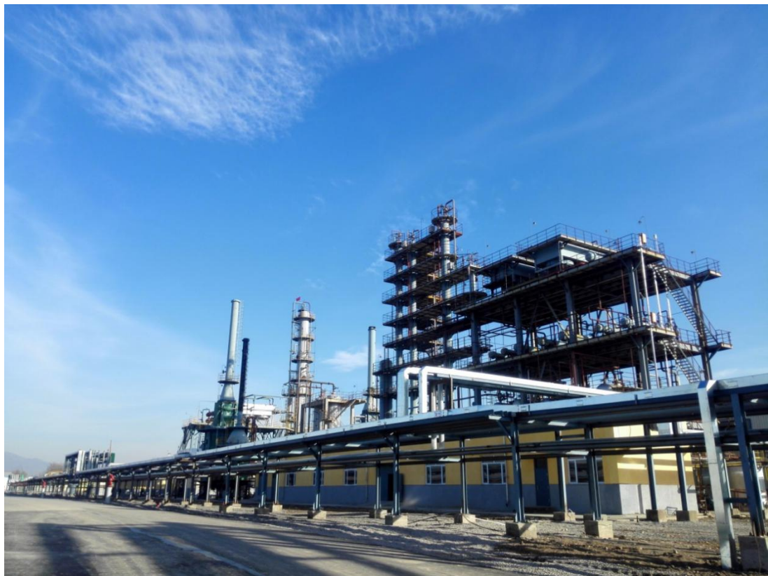
托克马克原油炼化厂实景拍摄
