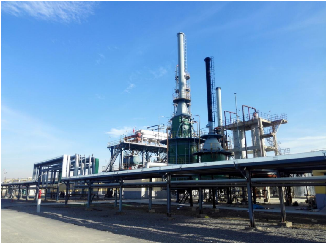
托克马克原油炼化厂实景拍摄
