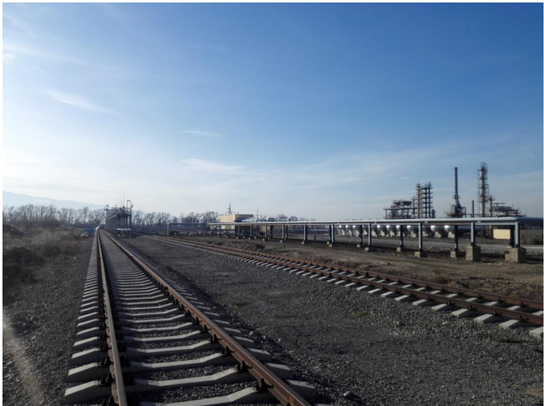
托克马克原油炼化厂实景拍摄
