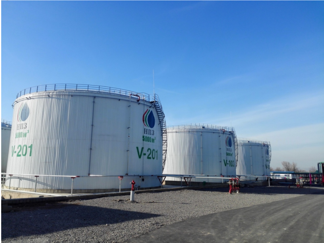
托克马克原油炼化厂实景拍摄
